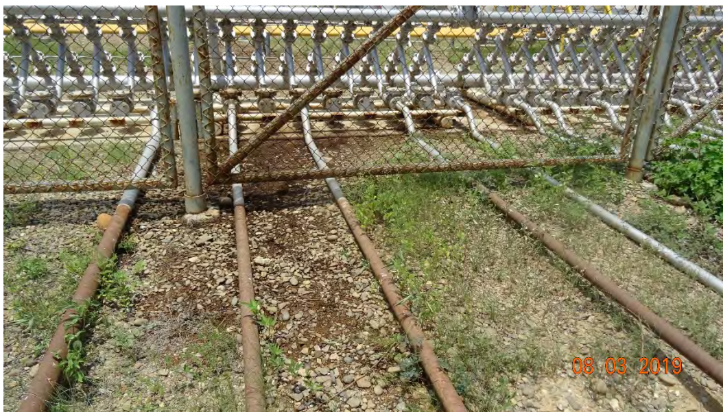
Fotografía 1. Bateria ZA-01 (Coordenadas WGS84-zona 17S: 484133mE, 9528213mN). Vista desde cerca del componente. Con indicio de derrame de hidrocarburos en el sistema de ducto que conduce al manifold próximo a la instalación.
