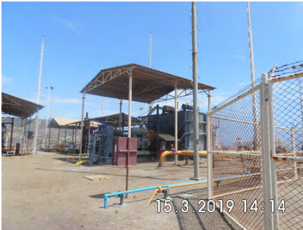
Fotografía 1. Estación de Compresión EPN-30 (Coordenadas WGS84-zona 17S: 472344mE, 9522922mN). Compresor con 5 Reciprocantes y 3 tornillos, capacidad nominal de 10.0 MMPDC. Vista desde cerca de la instalación. Sin indicio de derrame de hidrocarburos ni alteración de suelo.
