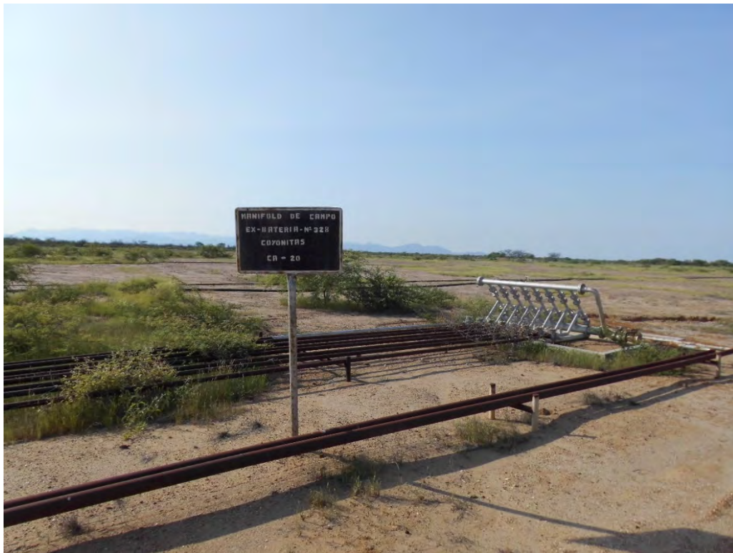
Fotografía 1. Manifold de Campo MC-20.01 (Coordenadas WGS84-zona 17S: 484922mE, 9514741mN), número de entradas de pozos: 8 líneas, líneas de 3" de diámetro y superficie de 20m 2 . Vista desde cerca del manifold de campo. Sin indicio de derrame de hidrocarburos ni alteración de suelo.
