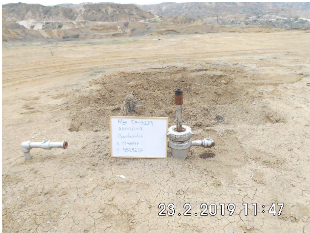
Fotografía 1. Pozo EA8229 (Coordenadas WGS84-zona 17S: 474847mE, 9525237mN), pozo inactivo tipo BM. Vista de cerca al pozo. Sin indicio de derrame de hidrocarburos ni alteración de suelo.
