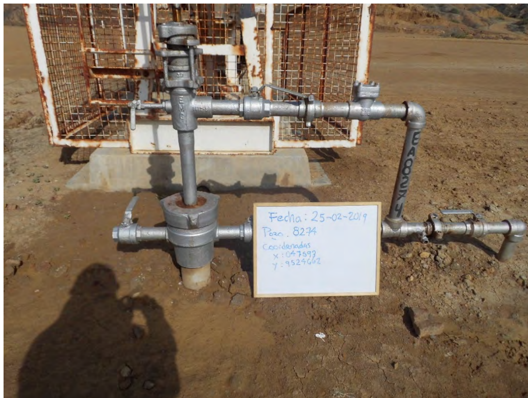
Fotografía 1. Pozo EA8274 (Coordenadas WGS84-zona 17S: 474593mE, 9524662mN), pozo productor tipo BM. Sin indicio de derrame de hidrocarburos ni alteración de suelo.
