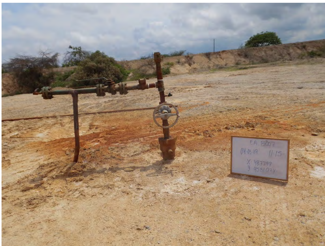
Fotografía 1. Pozo EA8007 (Coordenadas WGS84-zona 17S: 487799mE, 9531074mN), pozo inyector tipo ACTINYA. Vista desde cerca del pozo. Sin indicio de derrame de hidrocarburos ni alteración de suelo.
