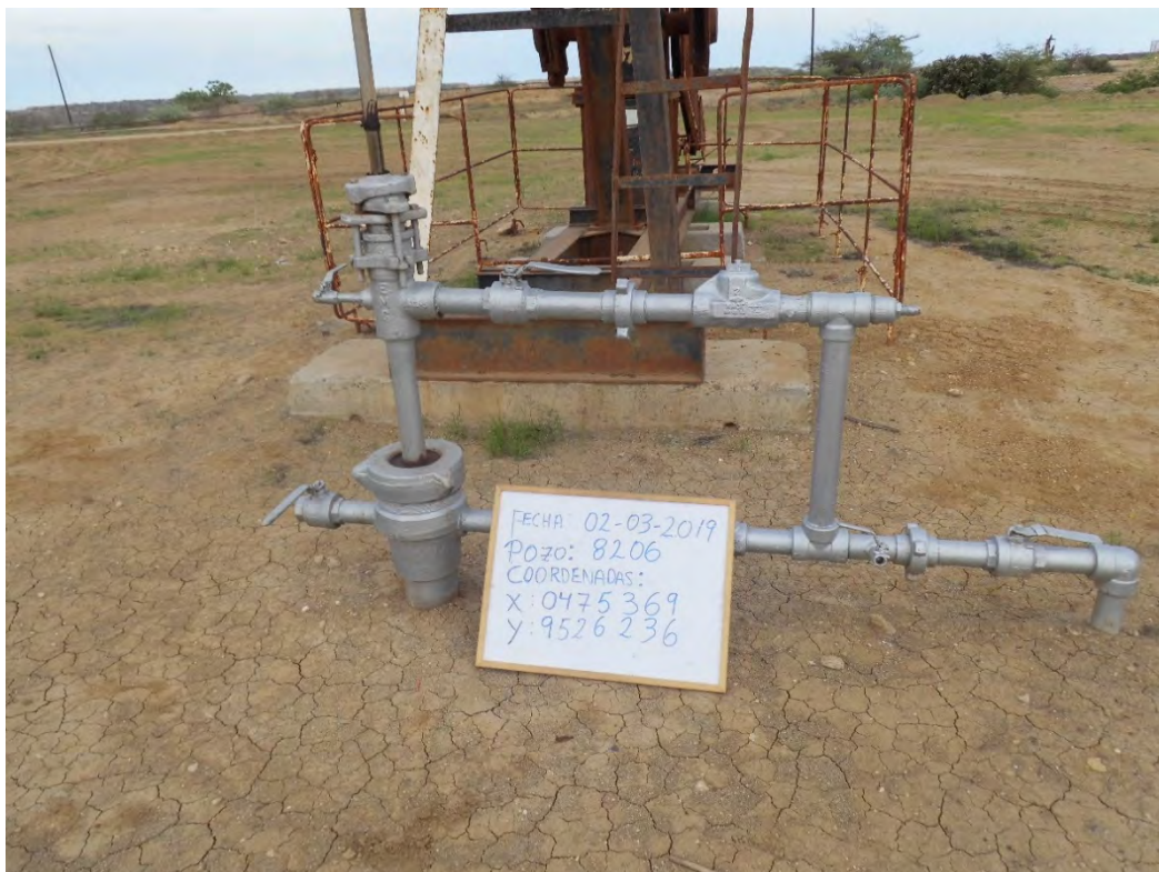
Fotografía 1. Pozo EA8206 (Coordenadas WGS84-zona 17S: 475639mE, 9526236mN), pozo productor tipo BM. Vista de cerca al pozo. Sin indicio de derrame de hidrocarburos ni alteración de suelo.
