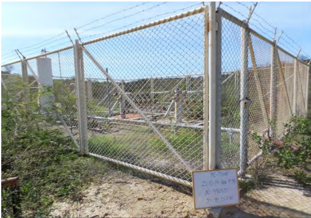
Fotografía 1. Manifold de Campo MC-09TUNAL (Coordenadas WGS84-zona 17S: 496535mE, 9533246mN), número de entradas de pozos: 10 líneas, líneas de 2" de diámetro y superficie de 150m 2 . Vista desde cerca del manifold de campo. Sin indicio de derrame de hidrocarburos ni alteración de suelo.
