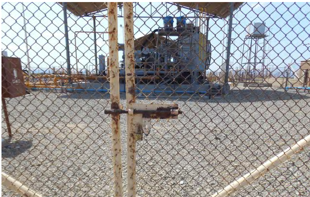
Fotografía 1. Estación de Compresión ECA-22 (Coordenadas WGS84-zona 17S: 479818mE, 9514661mN). Compresor tipo Reciprocantes, capacidad nominal de 4.0 MMPDC. Vista desde cerca de la instalación. Sin indicio de derrame de hidrocarburos ni alteración de suelo.
