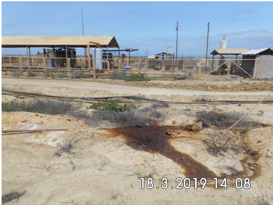
Fotografía 1. Estación de Compresión ETA-27 (Coordenadas WGS84-zona 17S: 473710mE, 9526024mN). Compresor de tipo Reciprocante, capacidad nominal de 2.5 MMPDC. Vista desde cerca de la instalación. Con indicio de derrame de hidrocarburos en la zona próxima a la estación, cerca del sistema de tubería.
