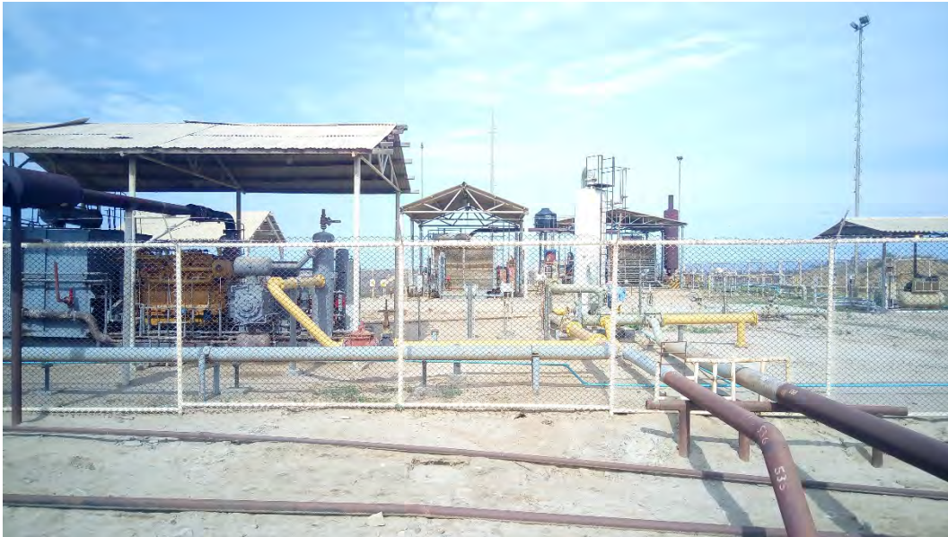
Fotografía 1. Estación de Compresión ETA-28 (Coordenadas WGS84-zona 17S: 477350mE, 9526238mN). Compresor de tipo Reciprocante, capacidad nominal de 3.5 MMPDC. Vista desde cerca de la instalación. Sin indicio de derrame de hidrocarburos ni alteración de suelo.
