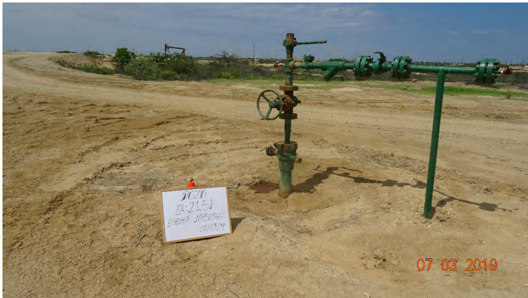
Fotografía 1. Pozo EA2151 (Coordenadas WGS84-zona 17S: 481417mE, 9529661mN), batería inyector inactivo tipo INACTINYA. Vista desde cerca del pozo. Sin indicio de derrame de hidrocarburos ni alteración de suelo.
