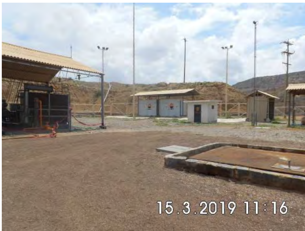
Fotografía 1. Estación de Compresión ETA-29 (Coordenadas WGS84-zona 17S: 474153mE, 9523339mN). Compresor de tipo Reciprocante, capacidad nominal de 2.0 MMPDC. Vista desde cerca de la instalación. Sin indicio de derrame de hidrocarburos ni alteración de suelo.
