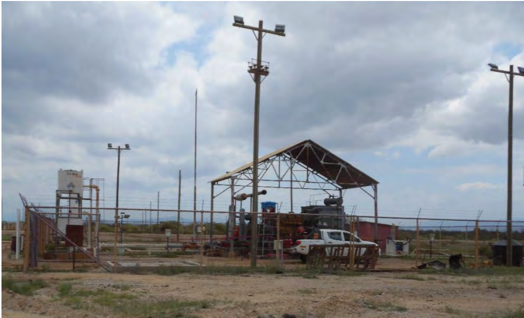
Fotografía 1. Estación de Compresión ECA-20 (Coordenadas WGS84-zona 17S: 485123mE, 9514920mN). Compresor tipo Reciprocantes, capacidad nominal de 1.0 MMPDC. Vista desde cerca de la instalación. Sin indicio de derrame de hidrocarburos ni alteración de suelo.
