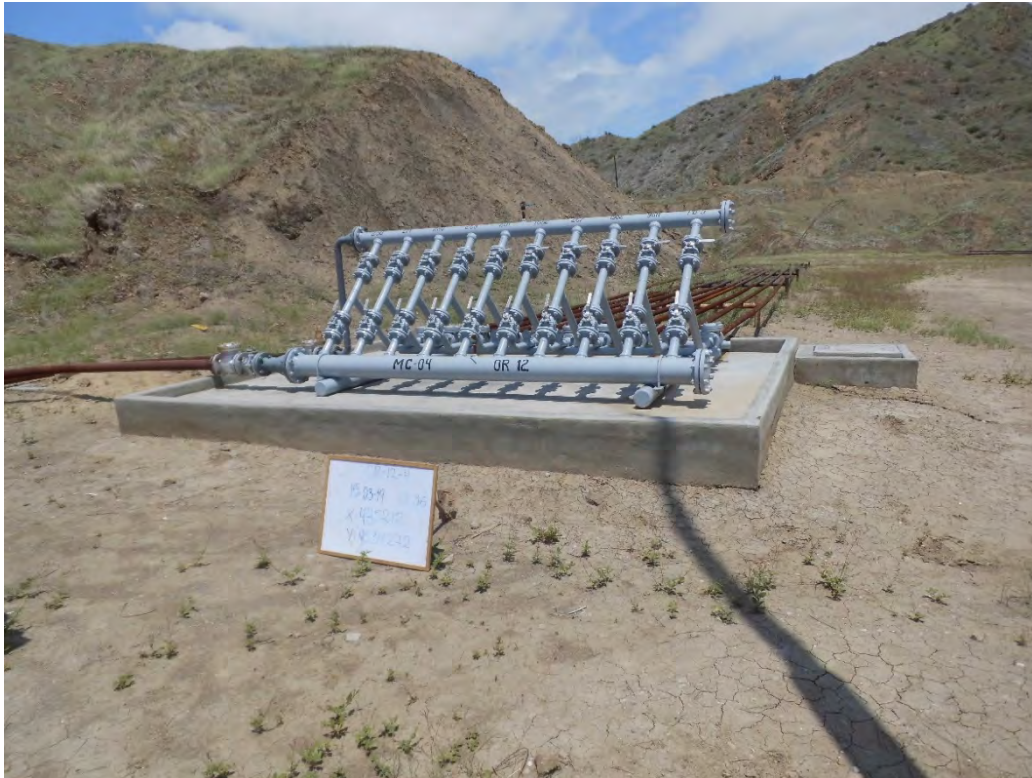
Fotografía 1. Manifold de Campo MC-12.04 (Coordenadas WGS84-zona 17S: 485212mE, 9534272mN), número de entradas de pozos: 10 líneas, líneas de 2" de diámetro y superficie de 24m 2 . Vista desde cerca del manifold de campo. Sin indicio de derrame de hidrocarburos ni alteración de suelo.
