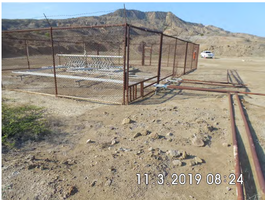
Fotografía 1. Manifold de Campo MC-11.09 (Coordenadas WGS84-zona 17S: 480524mE, 9533569mN), número de entradas de pozos: 5 líneas, líneas de 2" de diámetro y superficie de 25m 2 . Vista desde cerca del manifold de campo. Sin indicio de derrame de hidrocarburos ni alteración de suelo.
