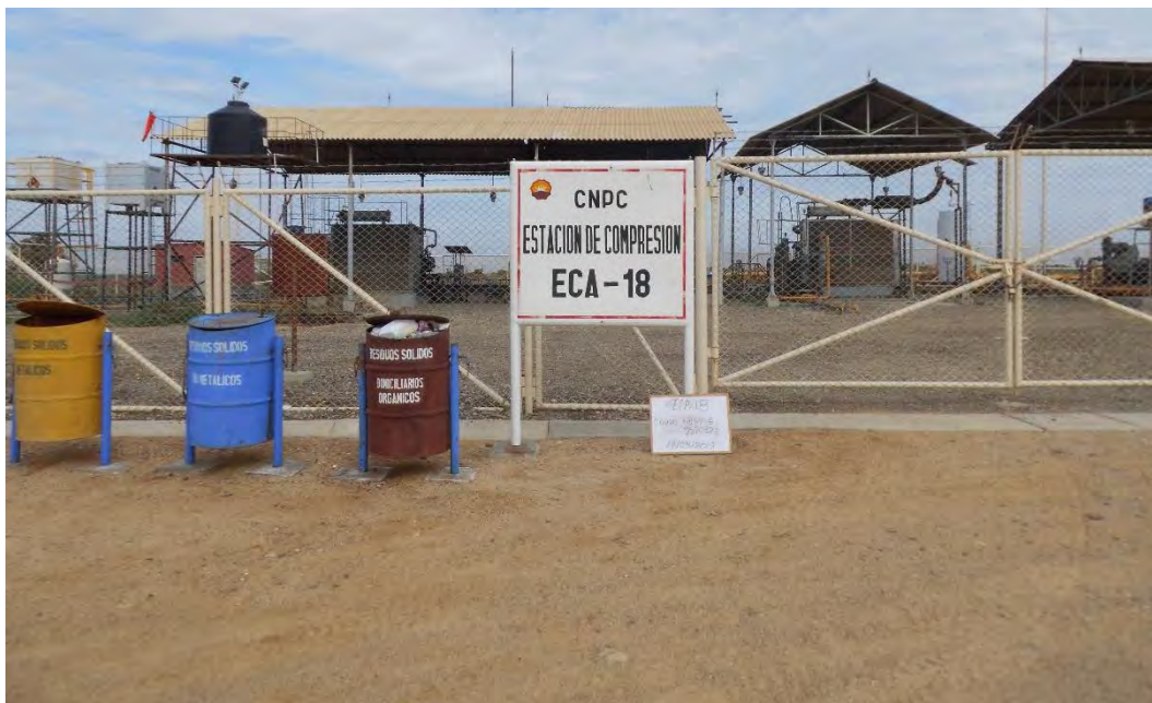
Fotografía 1. Estación de Compresión ECA-18 (Coordenadas WGS84-zona 17S: 485418mE, 9520322mN). Compresor tipo Reciprocantes, capacidad nominal de 3.0 MMPDC. Vista desde cerca de la instalación. Sin indicio de derrame de hidrocarburos ni alteración de suelo.
