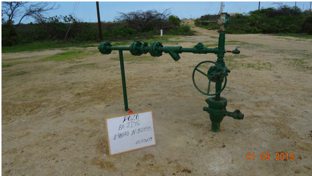
Fotografía 1. Pozo EA2146 (Coordenadas WGS84-zona 17S: 481170mE, 9529545mN), batería inyector tipo ACTINYA. Vista desde cerca del pozo. Sin indicio de derrame de hidrocarburos ni alteración de suelo.
