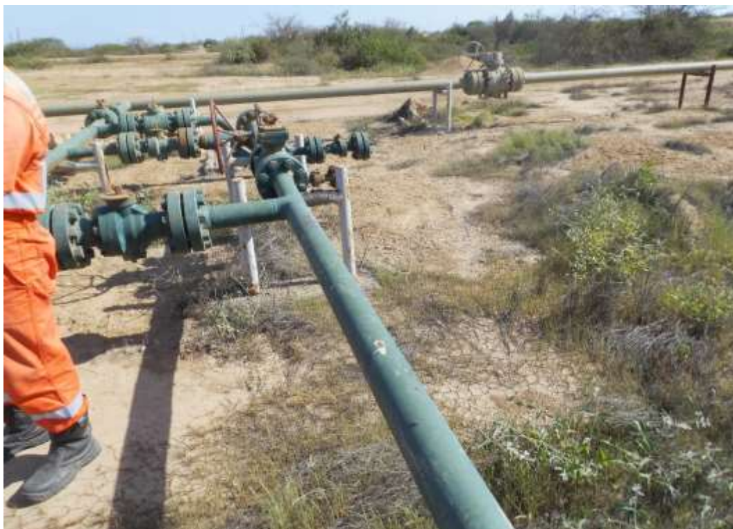
Fotografía 1. Acueducto progresiva inicial. Instalación inicial: Derivación acueductos principal Ballena a MC-204 (Coordenadas de inicio WGS84-zona 17S: 481113mE, 9527986mN), línea de 4" de diámetro. 640m de longitud. Sin indicio de derrame de hidrocarburos ni alteración de suelo.
