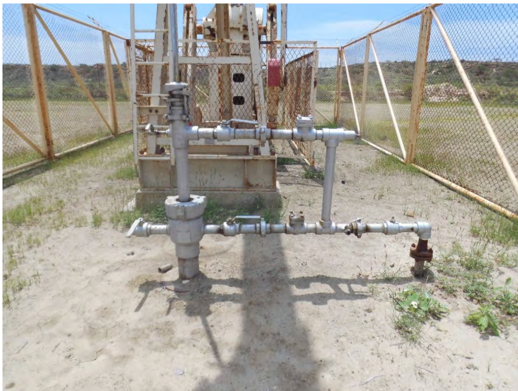
Fotografía 1. Pozo EA8632D (Coordenadas WGS84-zona 17S: 476827mE, 9529316mN), pozo productor tipo BM. Sin indicio de derrame de hidrocarburos ni alteración de suelo.
