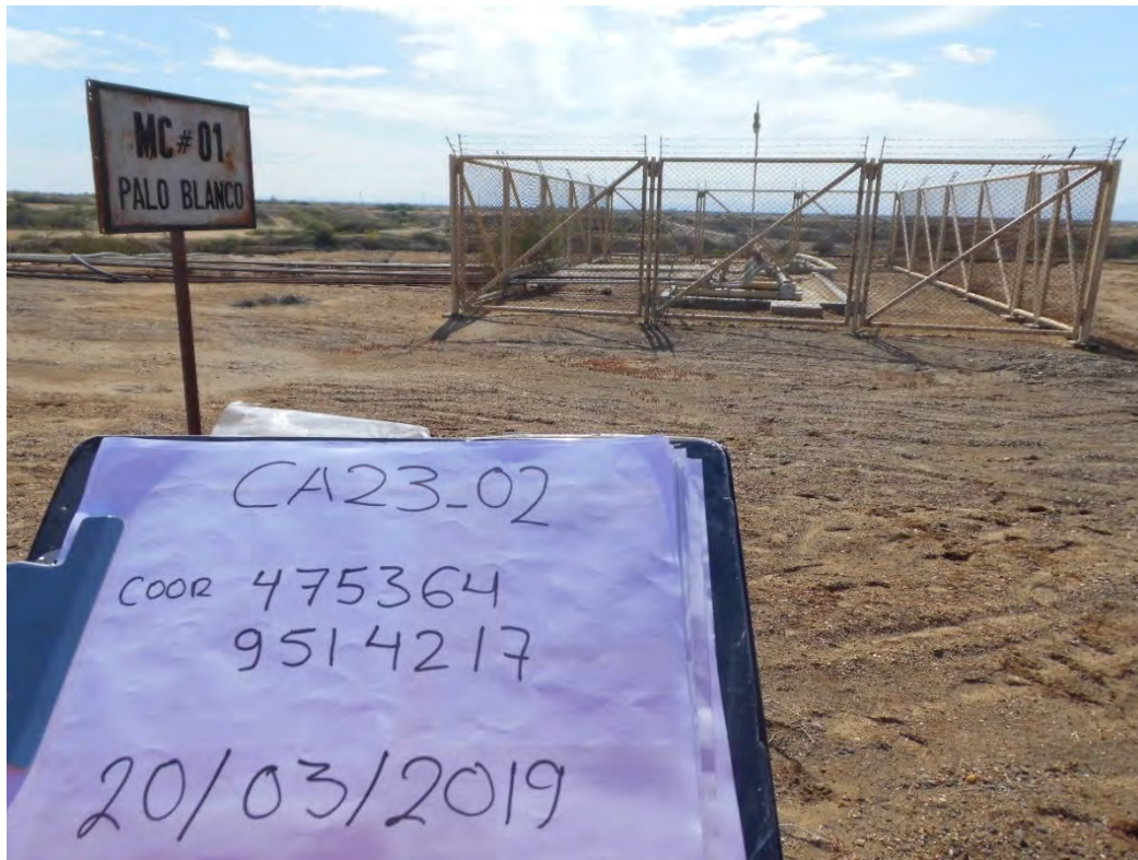
Fotografía 1. Manifold de Campo MC-23.02 (Coordenadas WGS84-zona 17S: 475364mE, 9514217mN), número de entradas de pozos: 18, líneas de 2" de diámetro y superficie de 40m 2 . Vista desde cerca del manifold de campo. Sin indicio de derrame de hidrocarburos ni alteración de suelo.
